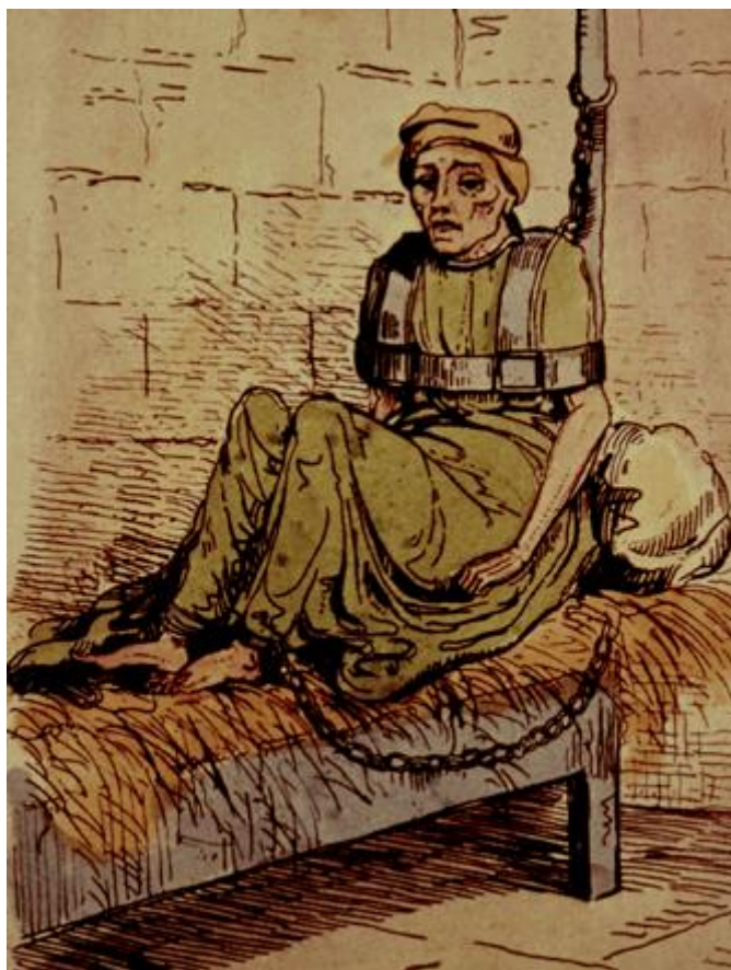
Slika 6. Pogled unutar azila Bedlam
